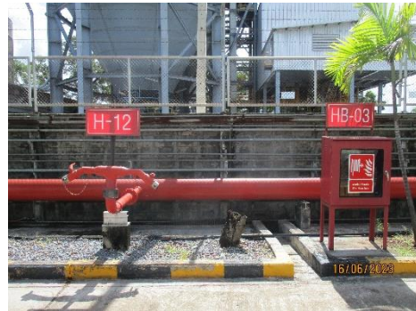
ภาพที่ 2-24 ระบบท่อน้ำดับเพลิง และสายฉีดน้ำดับเพลิง
