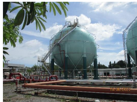
ภาพที่ 2-20 ระบบฉีดน้ำดับเพลิงบริเวณถังเก็บ ก๊าซปิโตรเลียมเหลว
